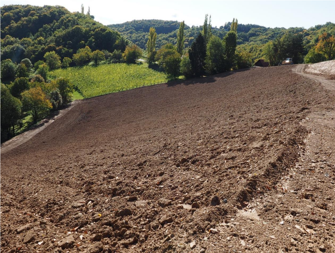
Erdarbeiten im Oktober 2021 abgeschlossen
