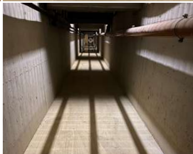
Unterflur - Zuluftführung
